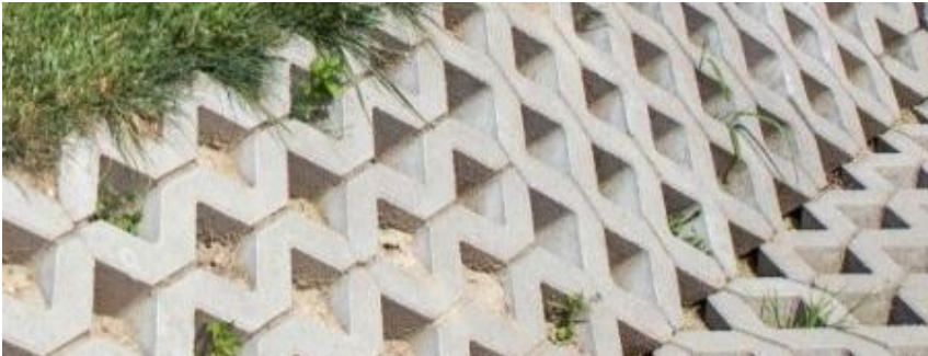
Gyephézagos beton gyeprácskő beépítési mintakép
