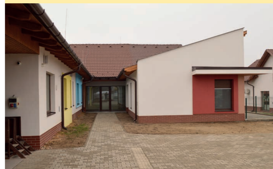
Hamarosan befejeződik a bölcsőde bővítése. A Területfejlesztési Operatív Program keretében elnyert 135 millió Ft forrásból az új bölcsőde épületének bővítése valósul meg. Két új csoportszoba, kiszolgálóhelyiségek és udvari homokozók kerülnek kialakításra.
