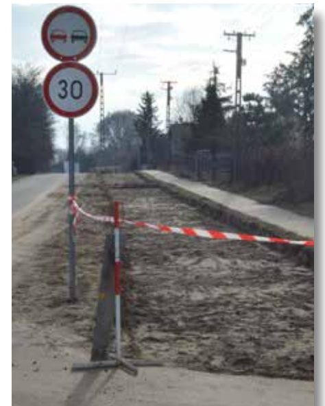
A kerékpárút felújítása és építése megkezdődött a Debreceni úton
